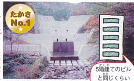
12 地藏堂第3砂防堰堤
