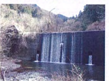
18 徳永第2砂防堰堤
