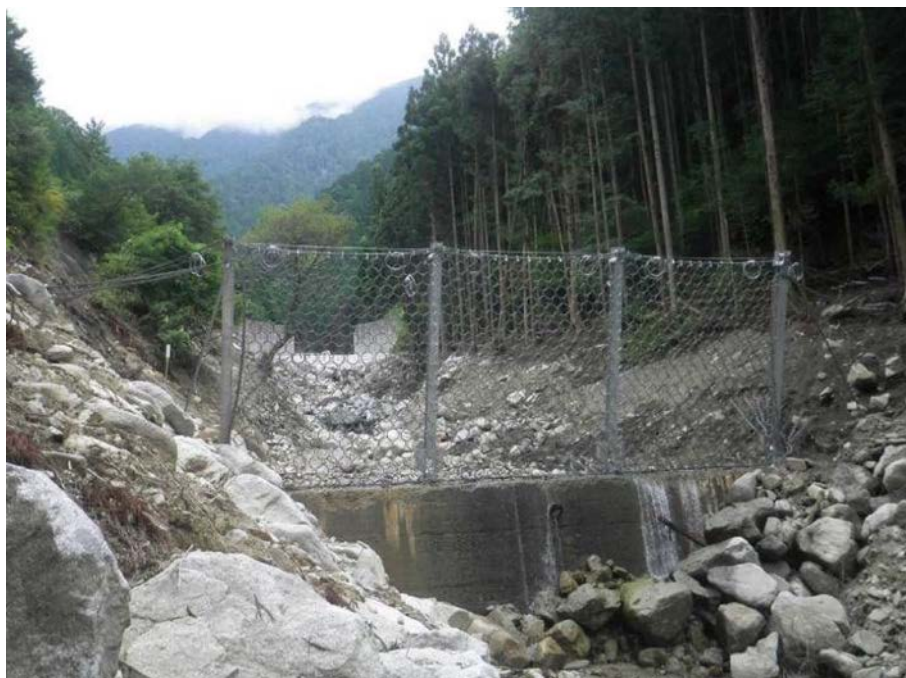
図 5.12.2 強靱ワイヤーネット工法（長野県南木曽町梨子沢）
