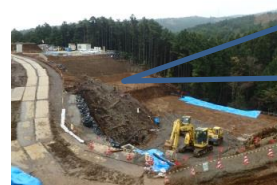
2号橋A2橋台
