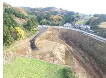
大曲工区 工事用道路
