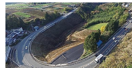
大曲工区着手前
