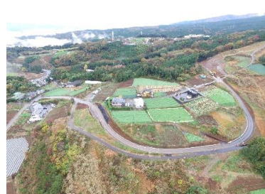
笹原工区 工事用道路
