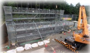
7号擁壁 進捗状況
