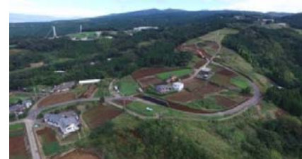
笹原工区 工事用道路 進捗状況
