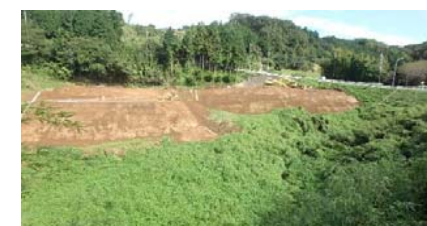
大曲工区着手前
