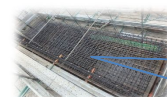
7号擁壁 底版鉄筋組立完了
