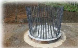
7号擁壁 深礎杭施工
