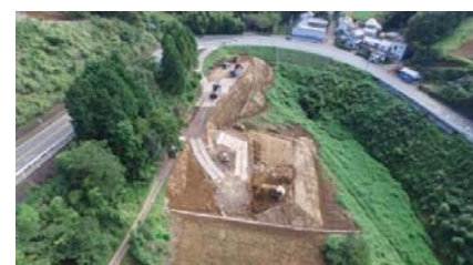
大曲工区 工事用道路 進捗状況
