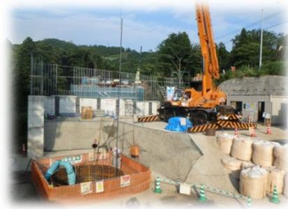
7号擁壁深礎工鉄筋組立状況
