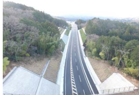
2号函渠より三島方面を望む
