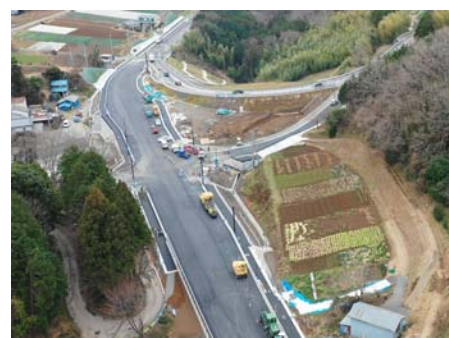
起点側より終点側を望む
