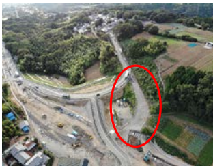
大曲部交差道路施工箇所
