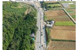
【工事終点側より大曲交差点を望む】
