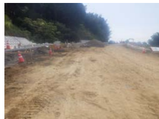
【終点より起点を望む】
