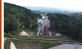
2号函渠より三島側を望む
