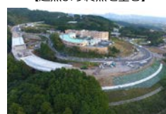
【終点より起点を望む】
