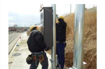
【電源引込柱に分電盤取付作業（参考）】
