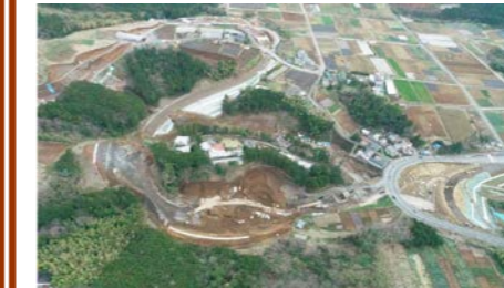
【工事起点から終点までを箱根側から望む】
