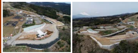
【6号函渠付近より望む】
