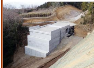
【4号橋A1橋台】 【8号、9号L型擁壁】 【4号函渠】
