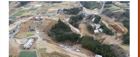
【上空から工事範囲全体を望む】
