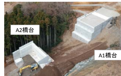
【A2側よりA1側を望む】
