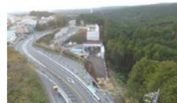
【1号補強土壁工】
