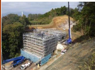
【4号橋A1橋台】 【4号函渠】
