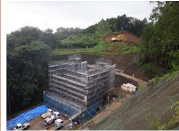
【4号橋 A1橋台】
