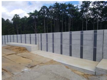
【3号現場打ちL型擁壁（道路右側）】
