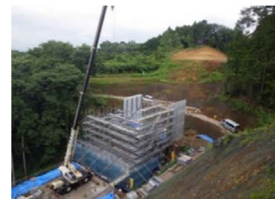
【4号橋 A1橋台】
