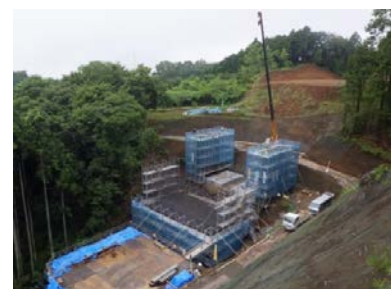
【4号橋 A1橋台】 【8号,9号L型擁壁】
