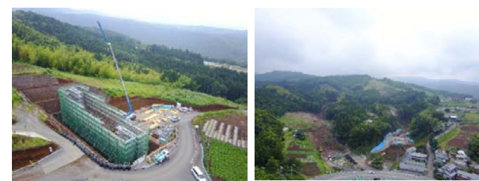
【3号函渠】 【本線工区】
