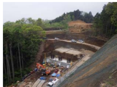
【4号橋A1橋台】
