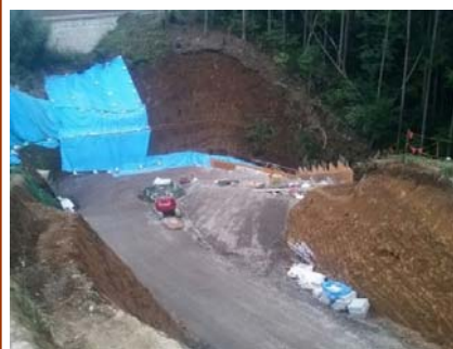
11月末 補強土壁
