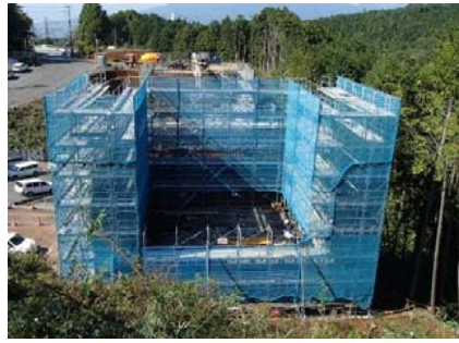
10月末 2号橋 A1橋台
