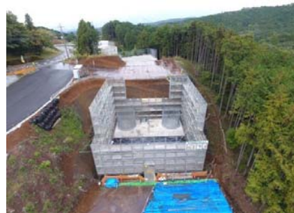
10月末 2号橋 A2橋台
