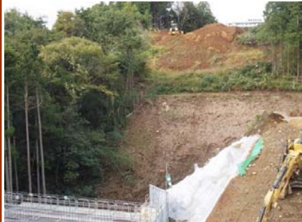
10月末 4号橋 A1橋台
