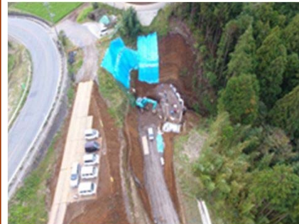
10月末 補強土壁
