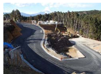
【エビノ木地区】 アスファルト 舗設完了
