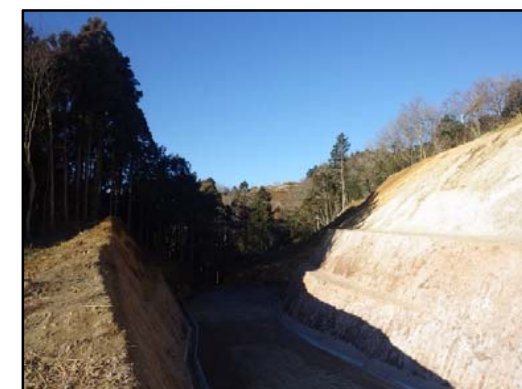
【4号橋】 A2橋台 施工箇所
