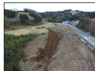
【大曲工区】 路体盛土施工状況
