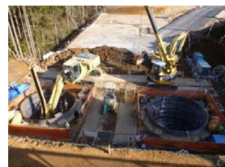
【エビノ木工区】 深礎杭掘削
