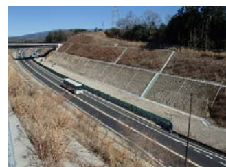
【大場工区】 法面掘削完了
