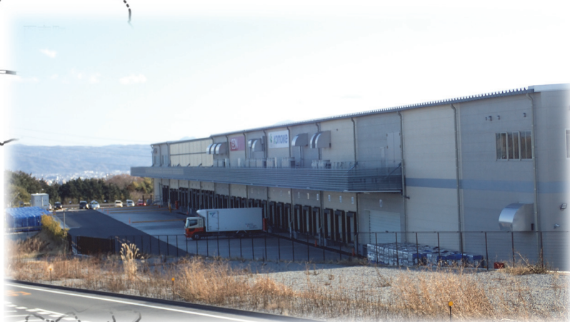
撮影：伊豆縦貫自動車道事業調整会議
