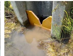
狩野川堤防整備（国土交通省） 田んぼダム調整板設置（三島市） ため池の事前放流（伊豆の国市）
