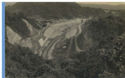
放水路工事着工 (昭和28年当時)
