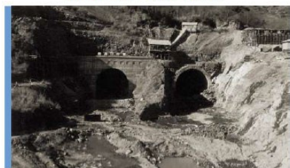
狩野川台風前 (昭和33年当時) の放水路
