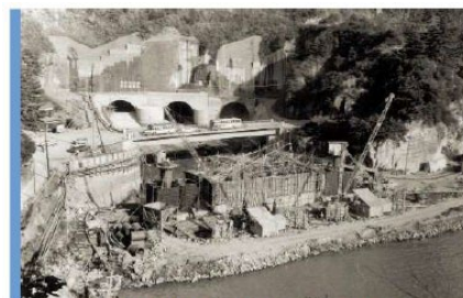
ケーソン埋設工事 (口野トンネル吐口側)
