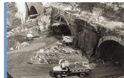
掘削土運搬 (長岡トンネル呑口側)
