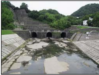
狩野川放水路
