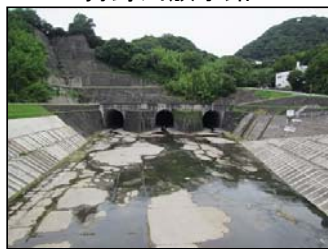
狩野川放水路
