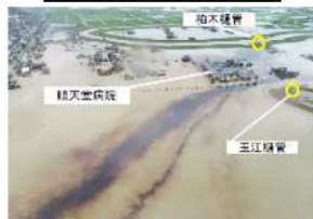
⑥六角川周辺における浸水被害 (佐賀県大町町)
