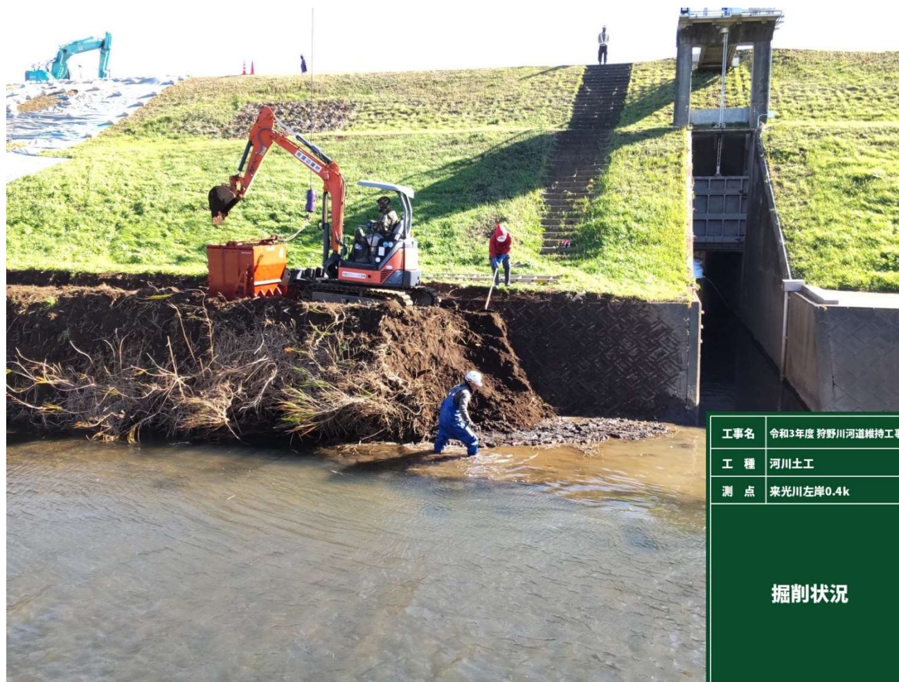
来光川左岸0.4kmの河道掘削状況
