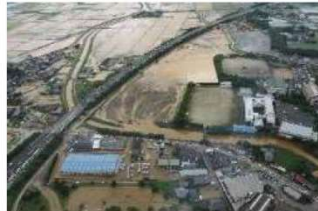
③桂川における浸水被害 (福岡県朝倉市)
