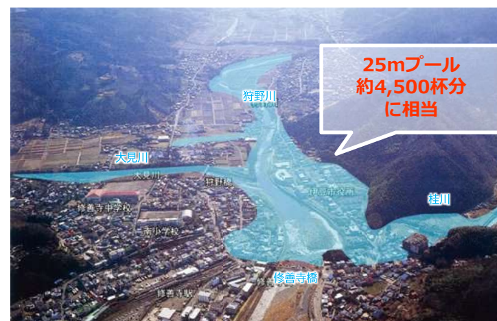
修善寺橋の閉塞によって上流にたまった水の範囲
