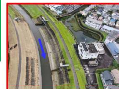
9 函南観音川排水機場の遠隔制御化(国)
