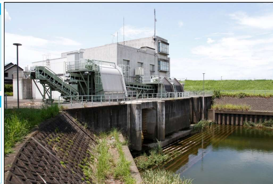
観音川排水機場
