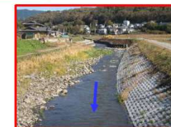
来光川堤防整備・護岸整備(県)
