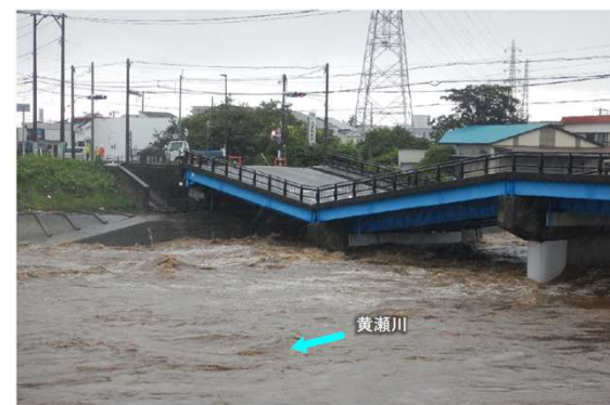
黄瀬川大橋橋脚、 橋梁の損傷
