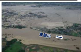
①鬼怒川の堤防決壊による浸水被害 (茨城県常総市)
