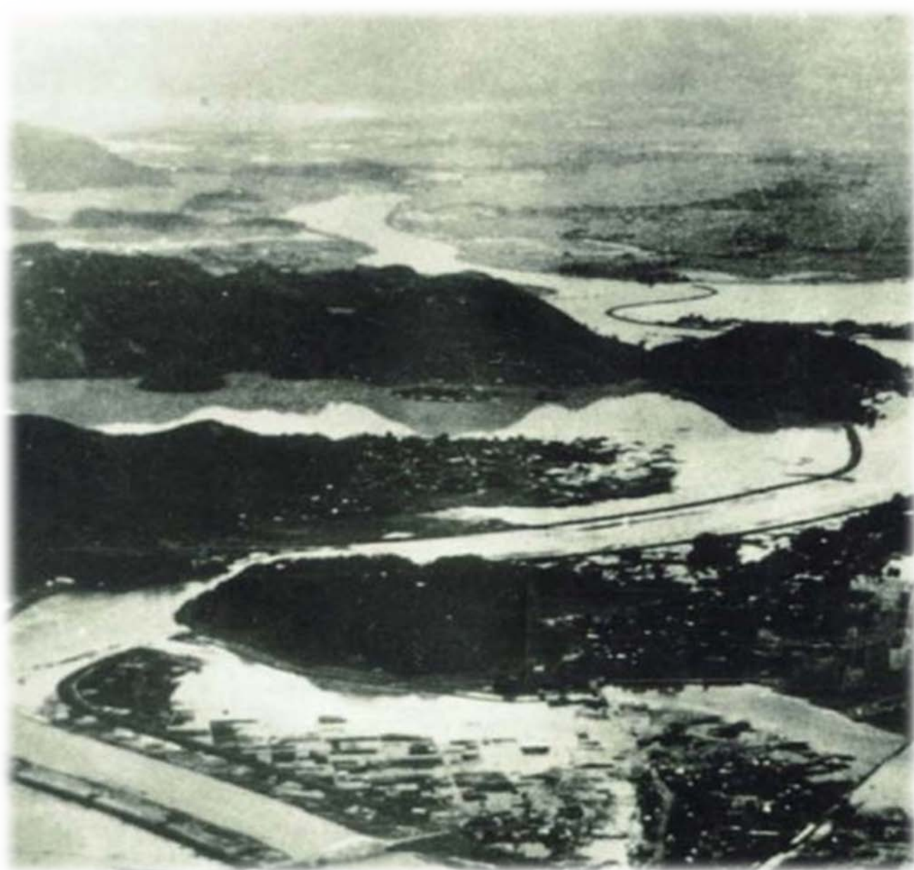
狩野川台風によって狩野川が氾濫し、一帯が浸水した田方平野
