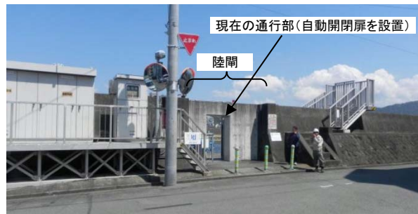
狩野川の下河原第3 陸閘と自動開閉装置 (堤内側の道路から望む)
