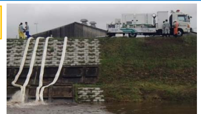
排水ポンプ車による排水状況
