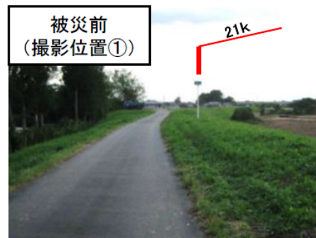
平成27年9月関東・東北豪雨による堤防の被災状況
