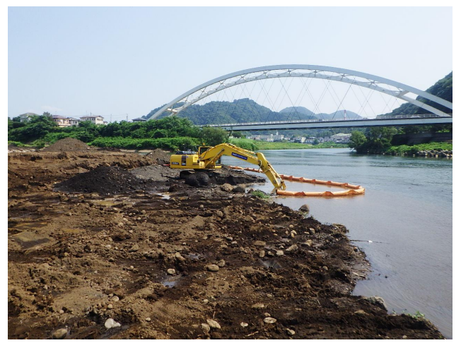
【事例】黄瀬川合流点付近の河道掘削
