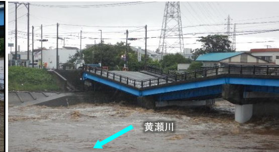
黄瀬川大橋橋脚、橋梁の損傷
