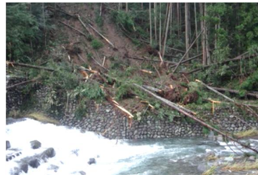
令和元年東日本台風における長野川左岸での斜面崩壊
