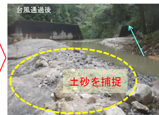
令和元年東日本台風に伴う流出土砂の捕捉状況(冷小第1砂防堰堤)
