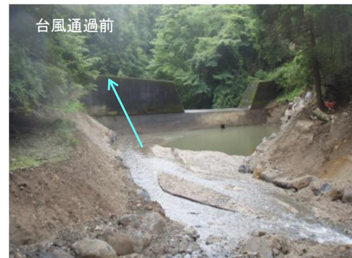
令和元年東日本台風に伴う流出土砂の捕捉状況(冷小第1砂防堰堤)
