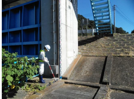
出水期前河川施設点検状況
