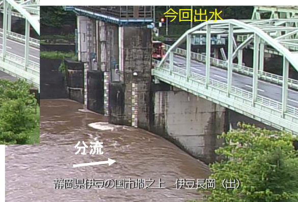
可動堰を開放し、放水路へ分流 (今回の出水では約3.5時間開放)
