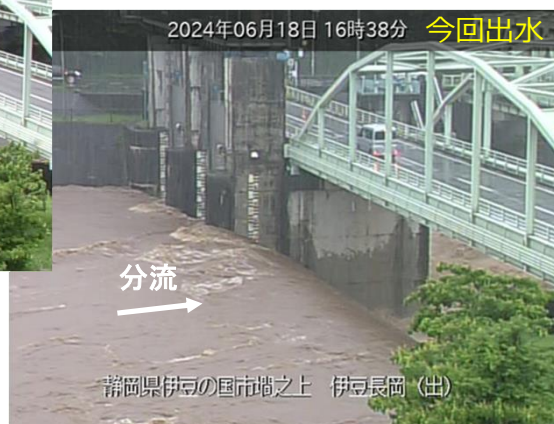
可動堰を開放し、放水路へ分流 （今回の出水では約12時間開放）
