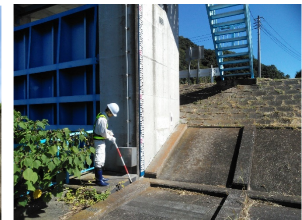
出水期前河川施設点検状況
