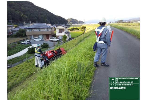
除草作業状況
