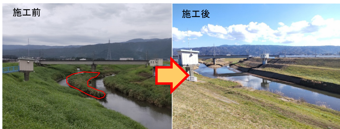
河道掘削実施状況(来光川0.6k付近)
