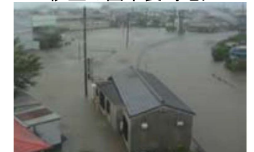
令和元年10月洪水 函南町間宮地区の浸水状況
