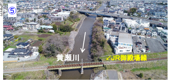
本宿河道掘削完成 R3.3完成
