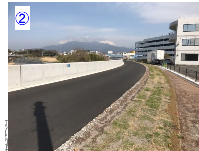
八幡工事完成 R3.3完成
