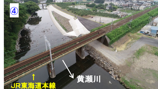
本宿工事完成 R2.3完成
