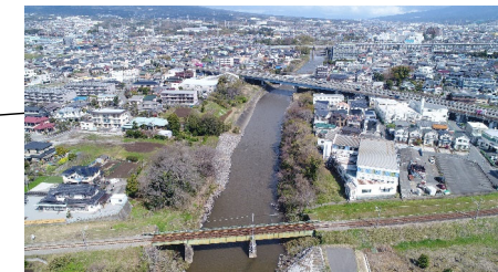
長泉町本宿地区 (河道掘削V=5.0千 m^3 )
