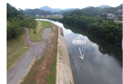
伊豆の国市寺家地区 (河道掘削 V=0.6千 m^3 )
