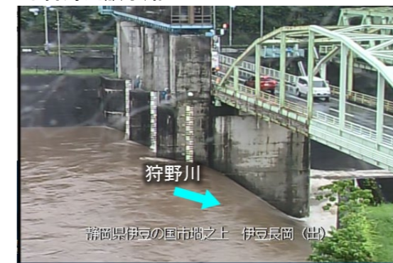
令和3年出水状況(7/3 12:10)
