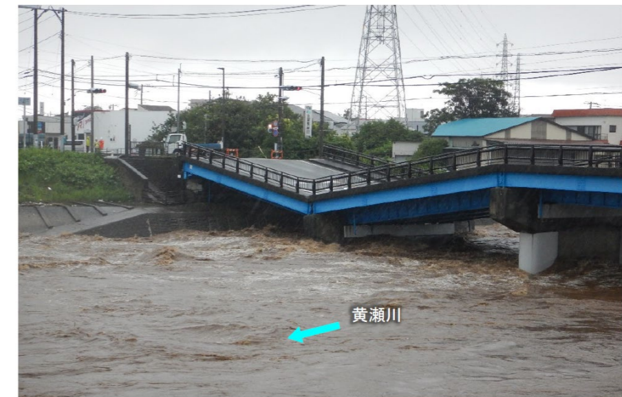
黄瀬川大橋橋脚、橋梁の損傷
