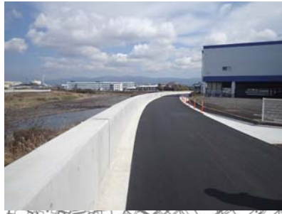
八幡工事状況 R2.2完成
