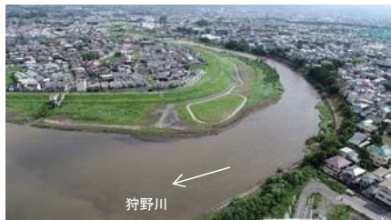
沼津市中瀬地区 (河道掘削V=6.1千m 3 )
