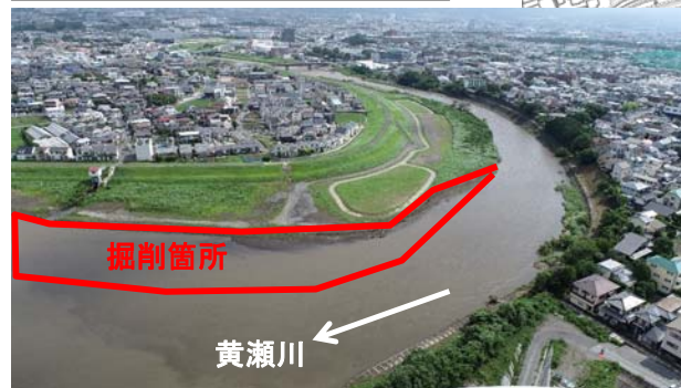
黄瀬川の掘削完了後写真R2.6
