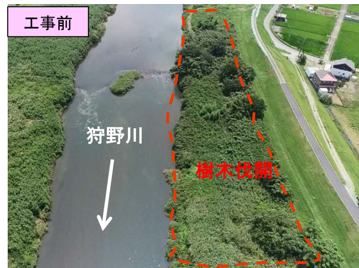
【狩野川左岸9.4k～11.0k】樹木伐開工事
