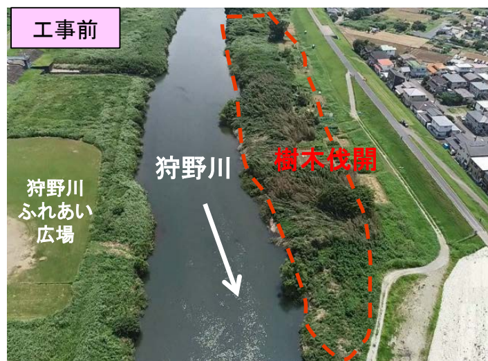
【狩野川左岸9.0k～9.2k】樹木伐開工事
