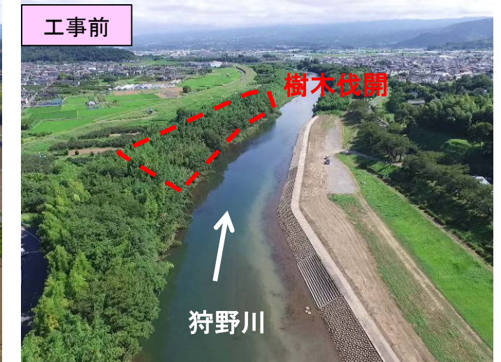
【狩野川左岸16.8k】樹木伐開工事
