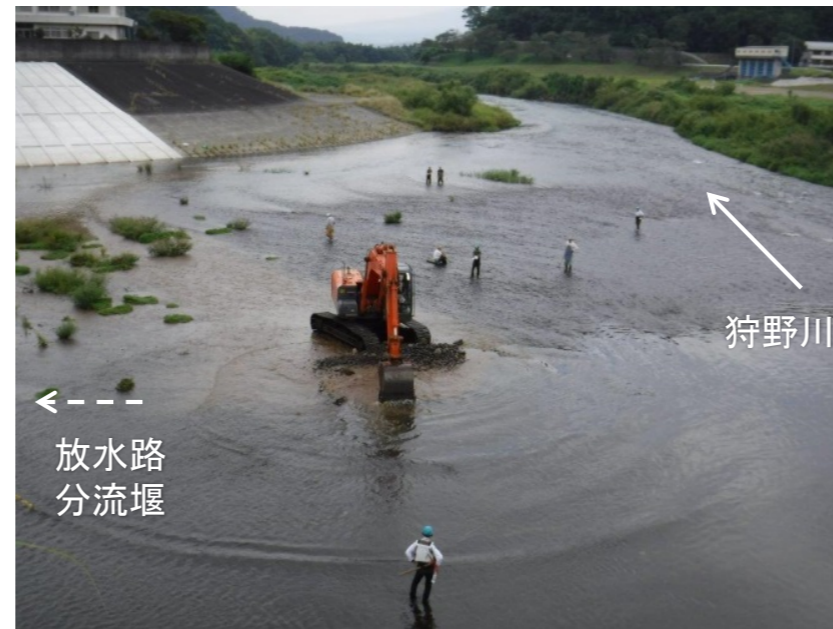
伊豆の国市 狩野川放水路分流堰付近でのアユ産卵場の造成作業(平成29年9月20日)
