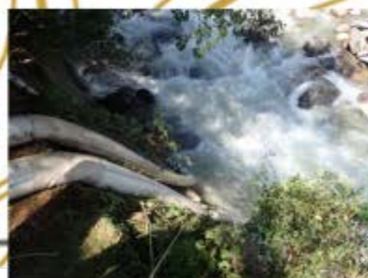
排水ポンプ車による取水
