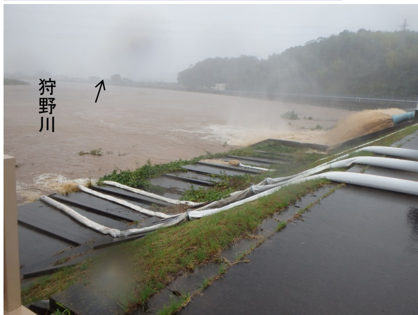
伊豆の国市宗光寺川における排水作業 10月12日
