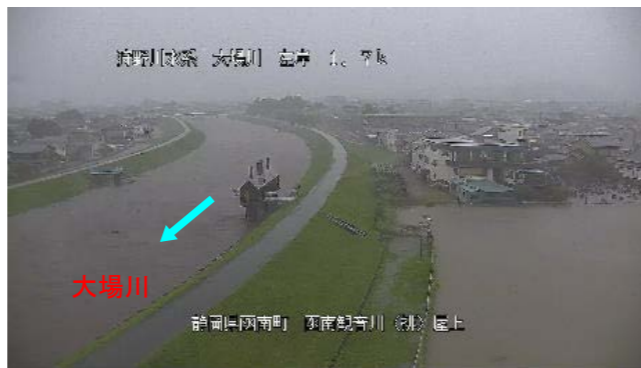
台風第19号による出水状況(10/12 15:00)
