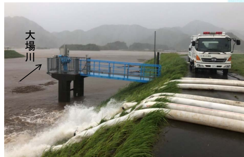
三島市御園地区における排水作業 10月12日
