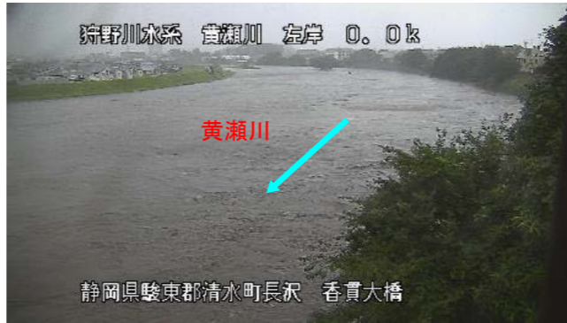
台風第19号による出水状況(10/12 14:00)
