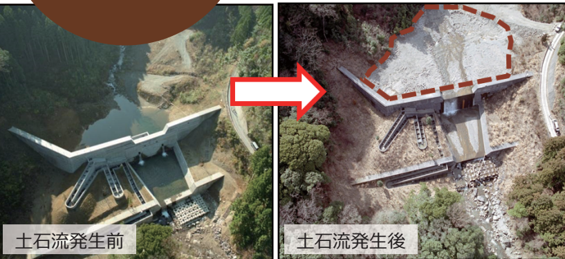
平成 15 年（2003 年）7 月の大雨による土石流を捕捉した猫越第 4 砂防堰堤
