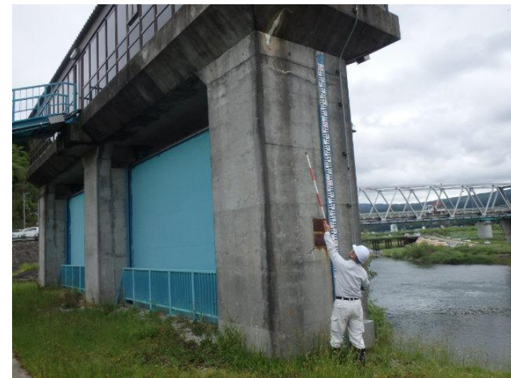
目的別巡視（徒歩）の様子 樋門等構造物詳細点検
