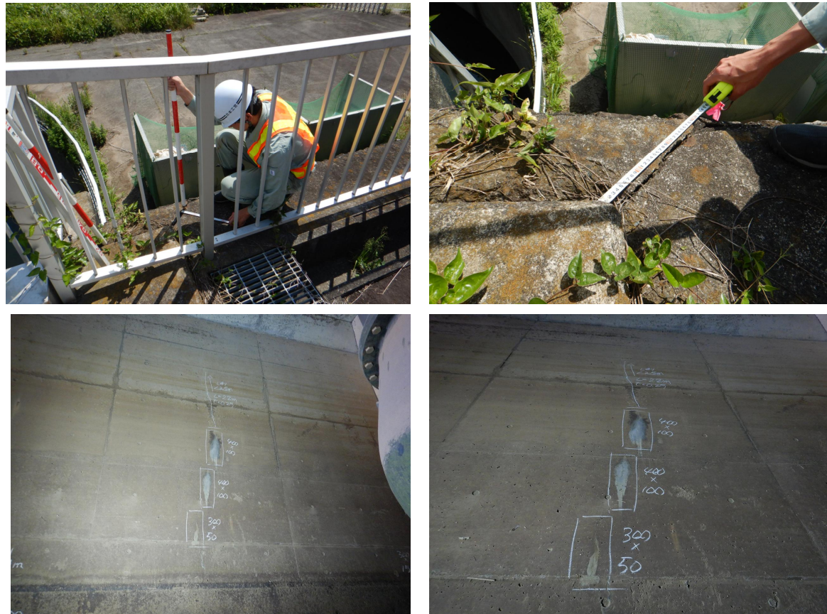
排水機場の土木施設の点検の様子
