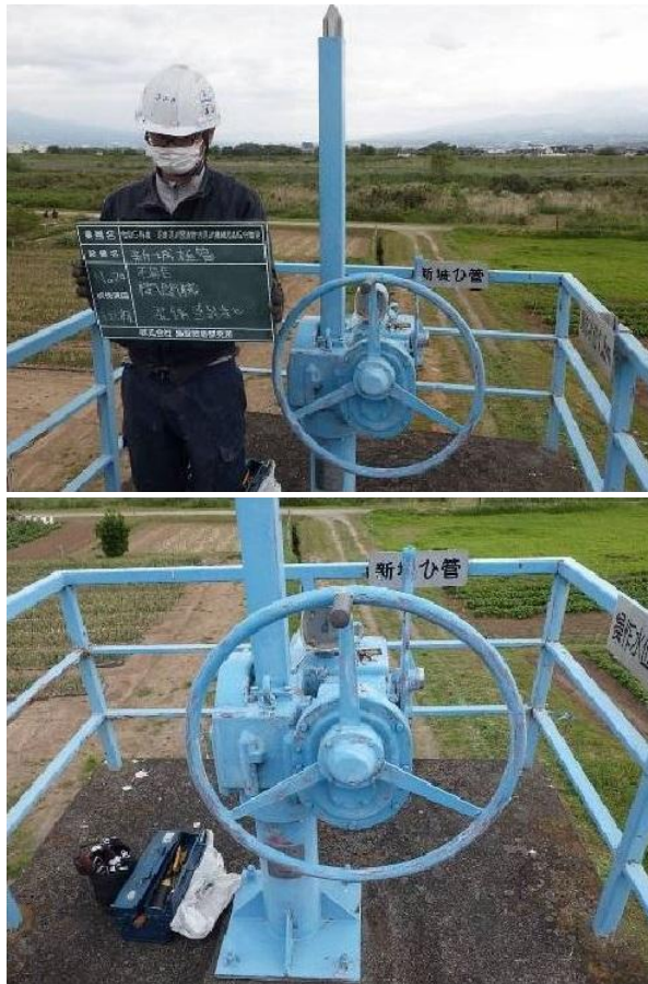
機械設備点検の様子
