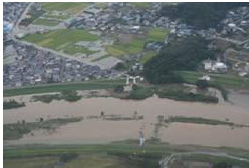
狩野川9.0km付近高水敷越水状況
