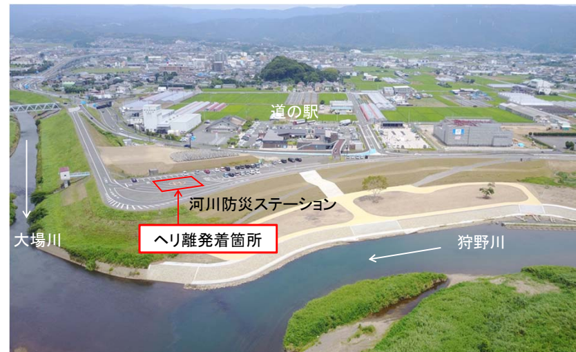
ヘリ離発着箇所(河川防災ステーション内)
