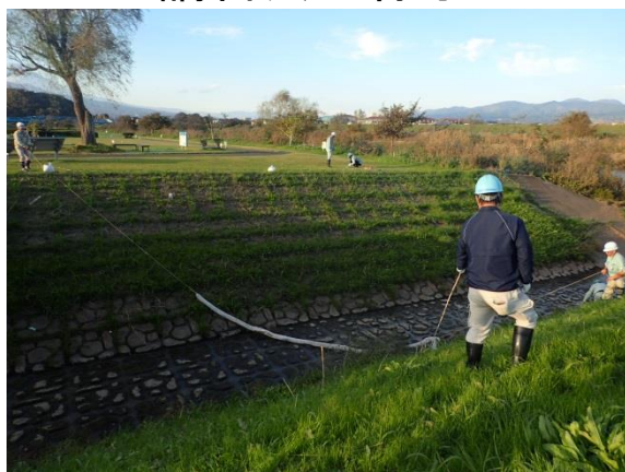
オイルフェンスの設置
