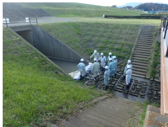
積み土のう工法
