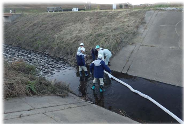
オイルフェンスの設置
