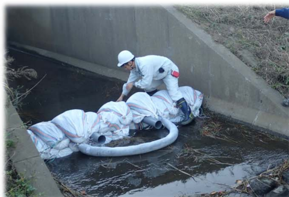
積み土のう工法
