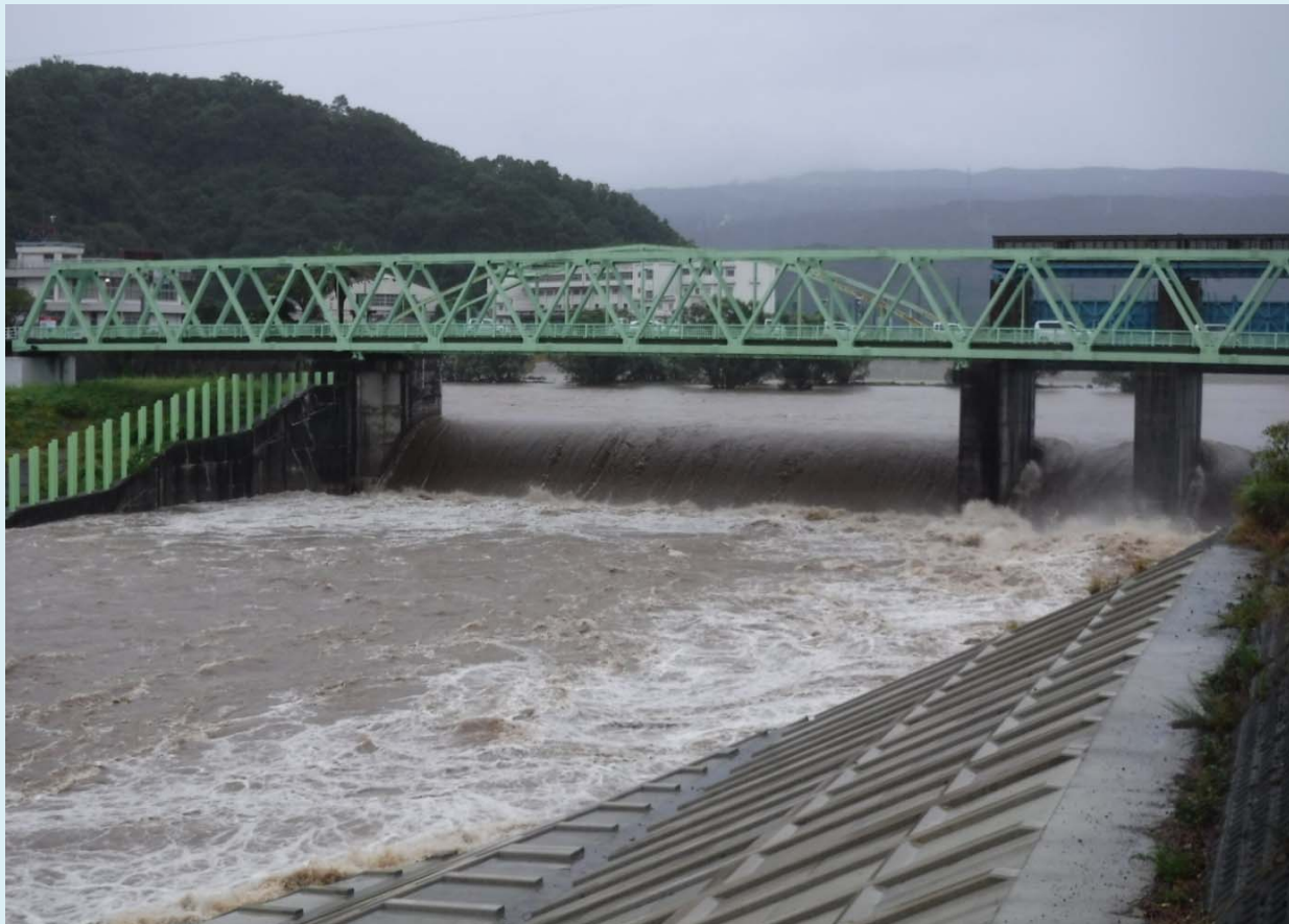
狩野川放水路の放流状況
