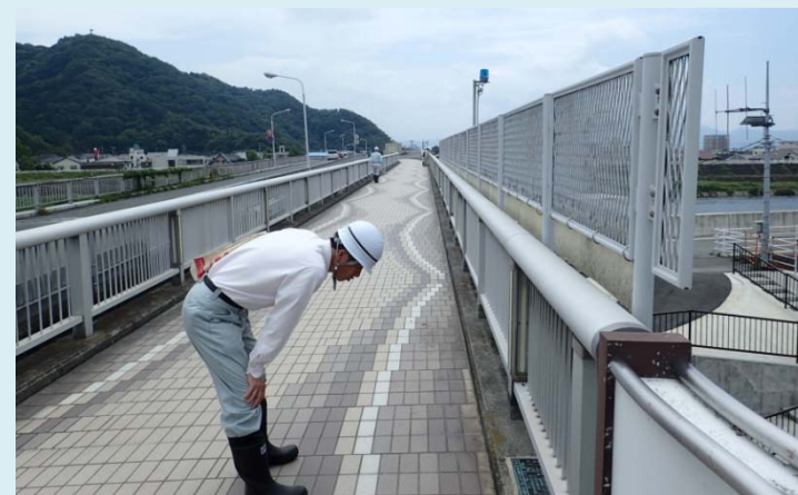
橋梁の点検状況
