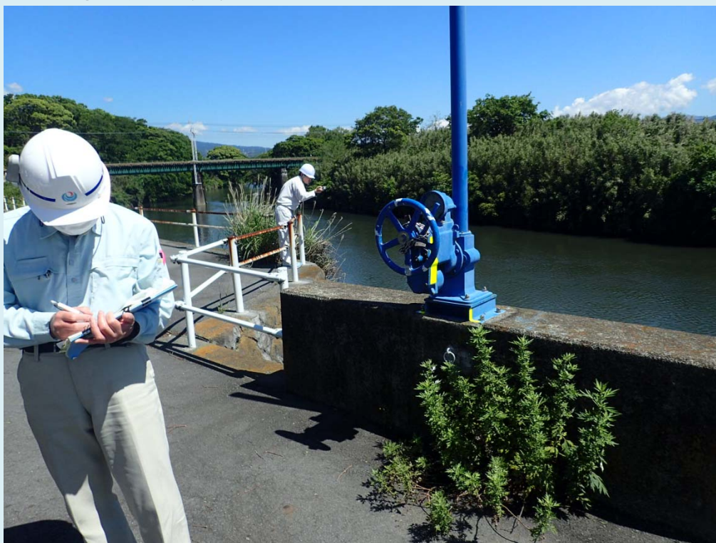
樋管の点検状況
