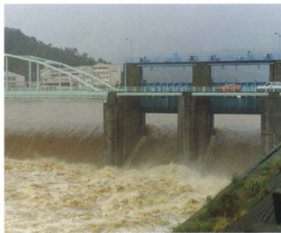
放水路分流堰の 放流状況
