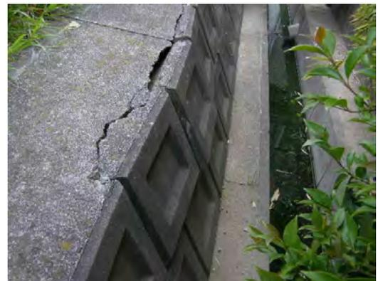
堤脚保護工及び堤脚水路（補修前）
