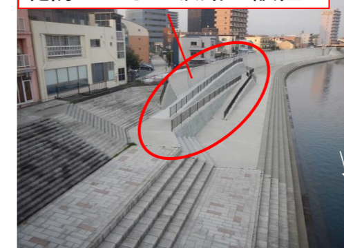
堤防上からの坂路の設置
