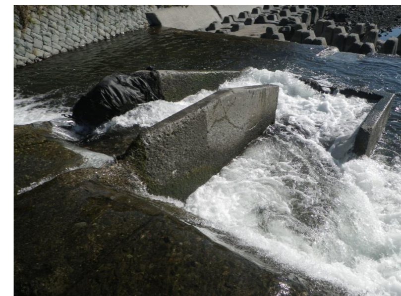
①-2 魚道状況(上流側より望む)
