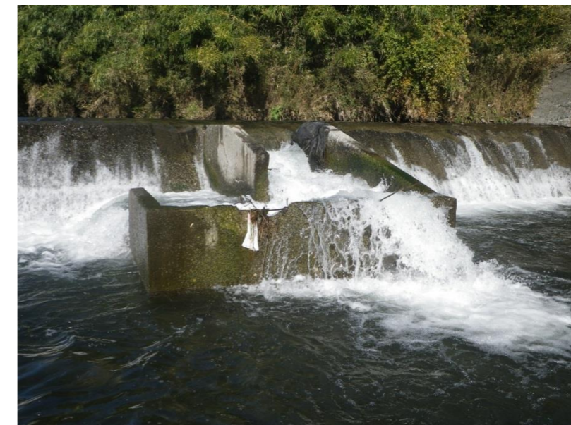
①-1 魚道状況(下流側より望む)
