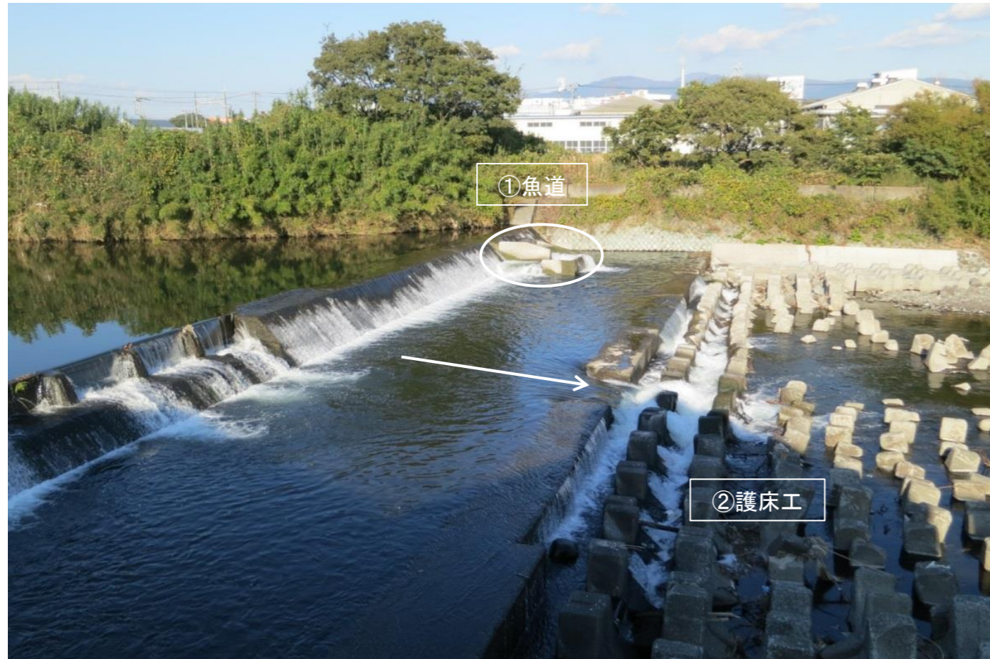
新田川用水堰 全景
